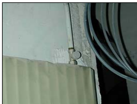
Vanne thermostatique placée juste au-dessus d'un radiateur : elle ne pourra travailler correctement
